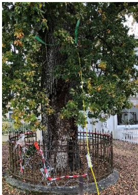
10 : Installation du câble sans mise en tension
