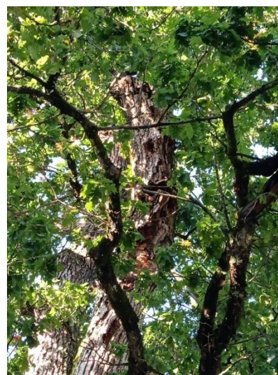
Photo n°7 : altération de la charpentièrre Nord
